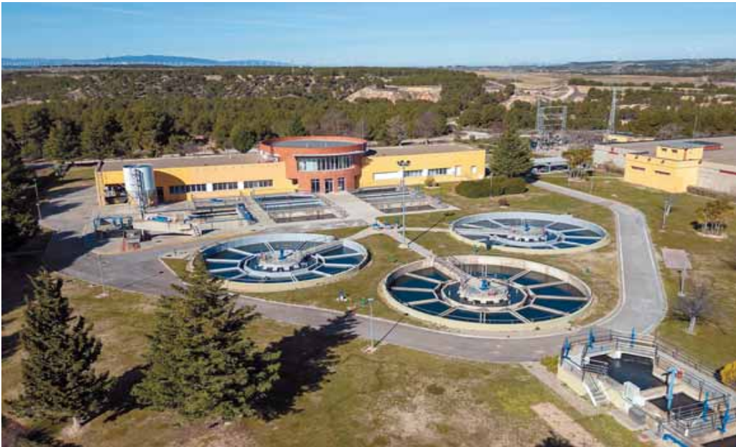
Imagen de la planta potabilizadora de Canraso en Tudela, en la que se invertirán 3,6 millones, 2,9 financiados por el Gobierno foral. BLANCA ALDANONDO
