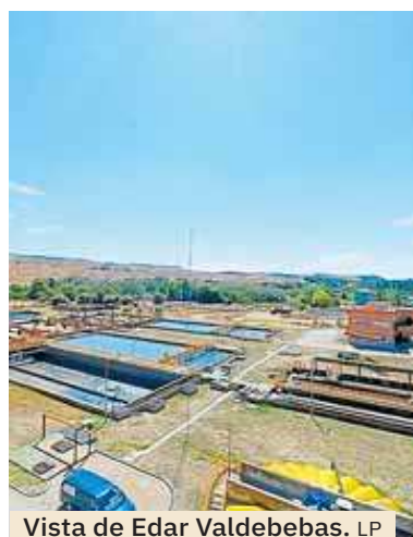
Vista de Edar Valdebebas. LP
